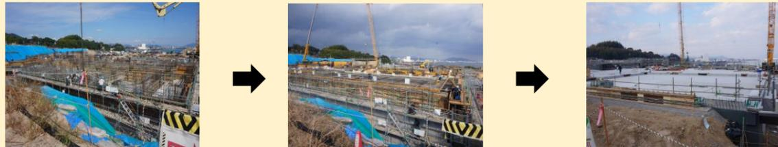
令和6年10月から建物本体工事にとりかかっています。建物の一部は、鉄筋コンクリート造のため、鉄筋・型枠を組み立て、コンクリートを流し込んで、固まれば型枠をはずす作業を繰り返して行っています。概ねこの作業が終わり、いよいよ建物の骨組みとなる鉄骨の組み立てがはじまります。
