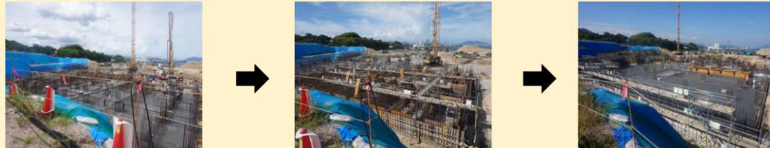
7月からは、建物基礎工事にとりかかっています。基礎は鉄筋コンクリート造のため、鉄筋・型枠を組み立て、コンクリートを流し込みます。一定の養生期間後に型枠を外します。この一連の工程を繰り返し、基礎工事は完了となります。なお、建物の一部区域では基礎工事を終え、10月から本体工事に取り掛かります。
