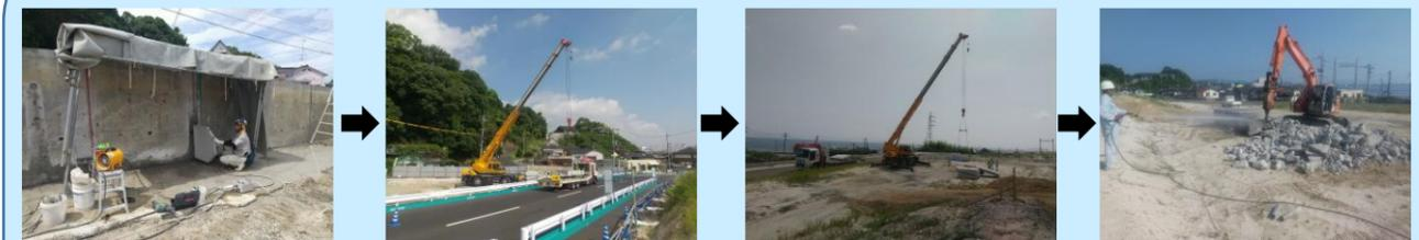
いこいと学びの交流テラスでは、周辺の住環境に配慮をしながら工事を行っています。写真は、市道黒磯町1号線の道路脇にあったコンクリートの壁を壊している様子です。住宅地に近いため、元々あった場所で壊さず少しずつ切り分け、住宅地から離れた場所に運んでから壊し、騒音や振動の発生をできるかぎり抑えるようにしています。
