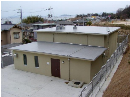
通津ポンプ所
