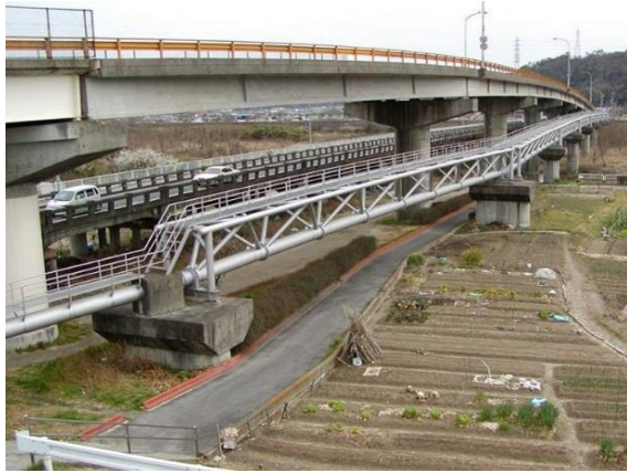
愛宕橋水管橋
