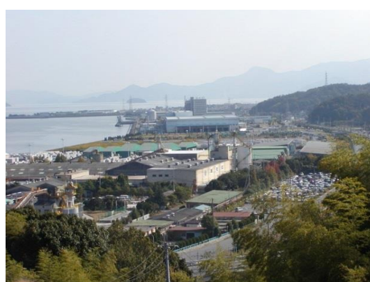
給水先 通津沖工業団地
