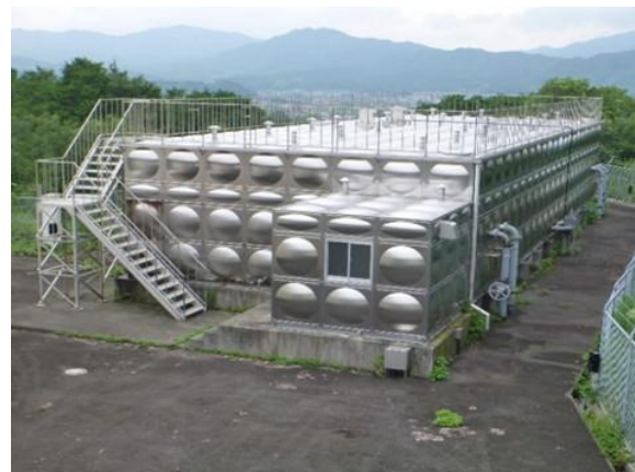
高森南配水池
