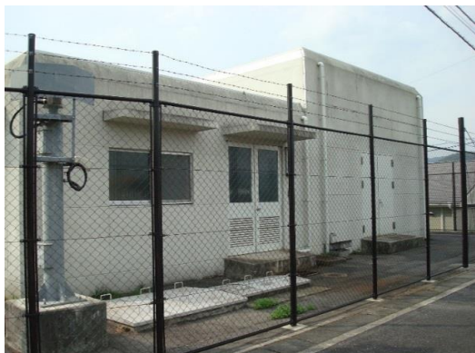
平田ポンプ所
