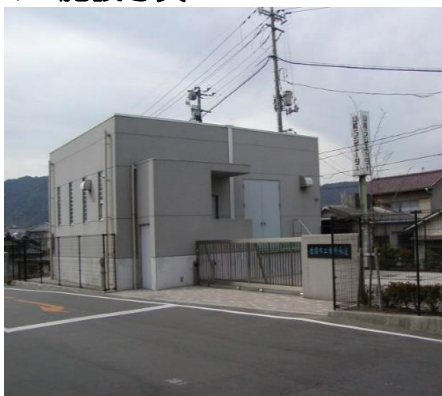
ポンプ所外観
