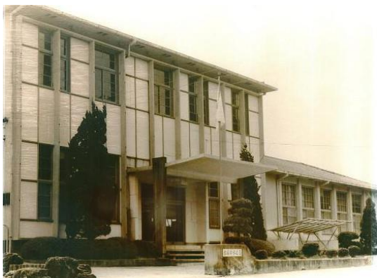
旧水道局庁舎（今津町6-2-23） 〈昭和35年～昭和48年〉
