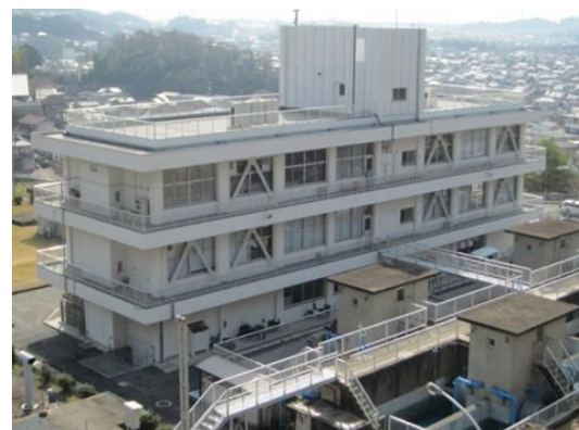
現錦見浄水場管理棟 ※耐震補強済み （岩国4-10-1）
