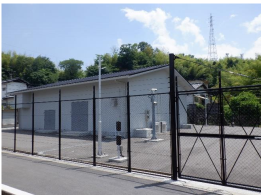
牛野谷送水ポンプ所
