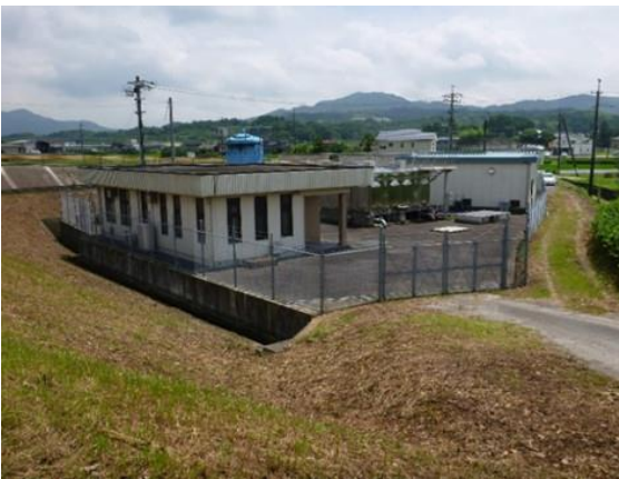
高森南浄水場
