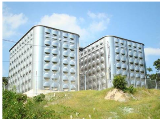
山手ブロック配水池
