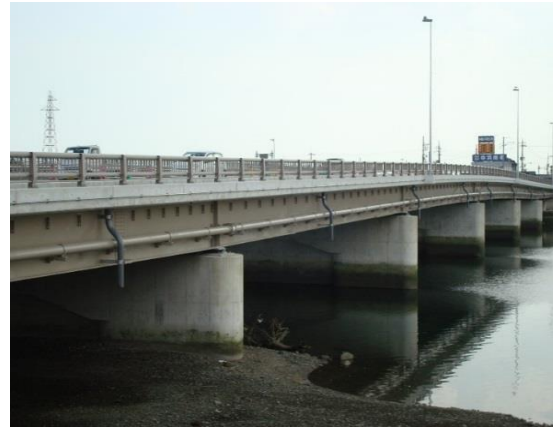
新寿橋添架配水管
