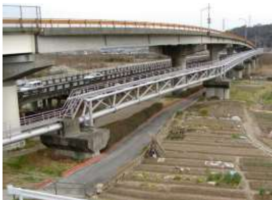
愛宕橋水管橋
