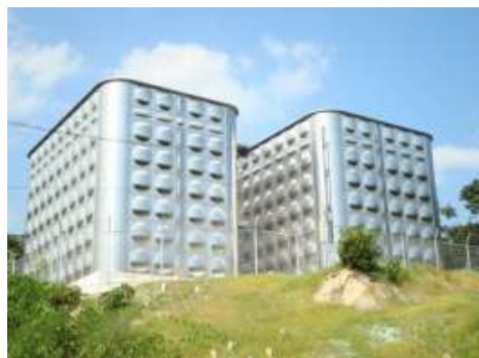
山手ブロック配水池
