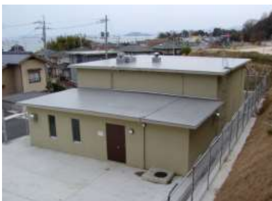
通津ポンプ所
