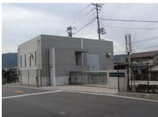
ポンプ所外観
