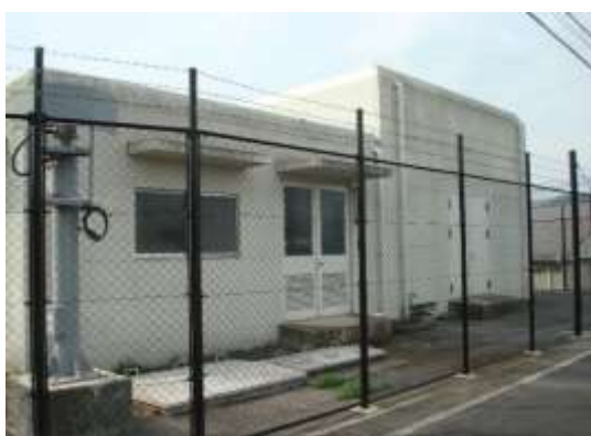
平田ポンプ所
