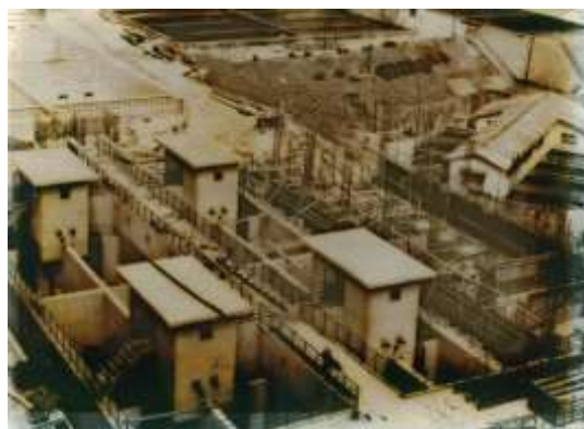
錦見浄水場管理棟（昭和46年工事中）
