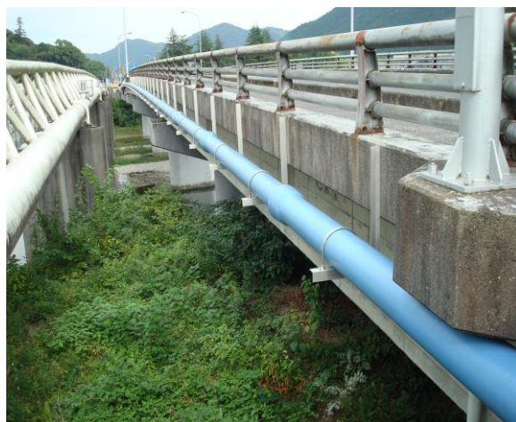
御庄大橋添架配水管
