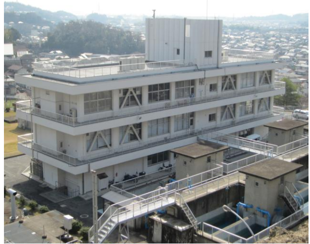
現錦見浄水場管理棟
