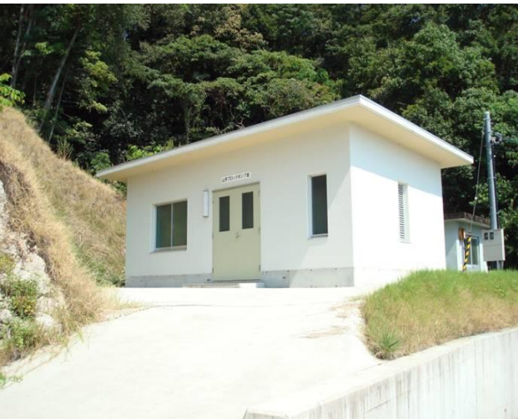
山手ブロックポンプ所
