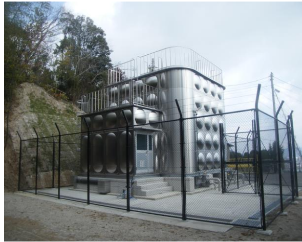
尾津一の谷団地配水池
