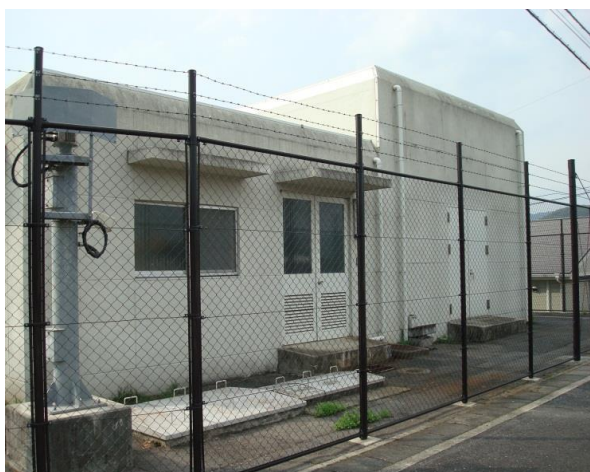
平田ポンプ所
