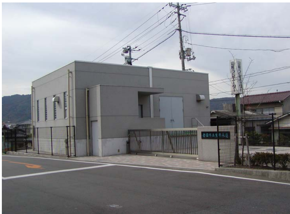
ポンプ所外観
