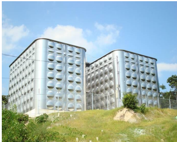
山手ブロック配水池
