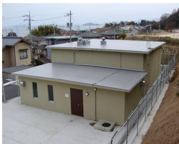
通津ポンプ所
