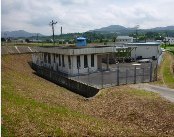
高森南浄水場
