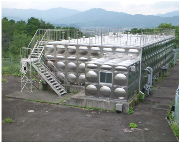
高森南配水池
