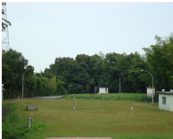
牛野谷配水池
