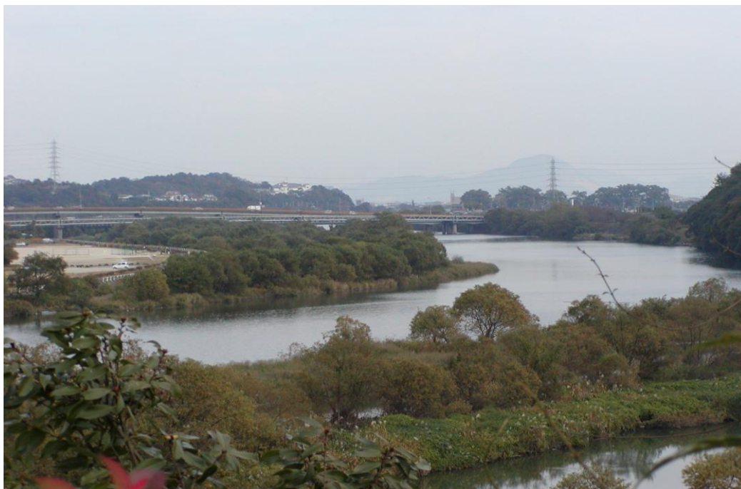
錦川（伏流水 集水埋管にて取水）
