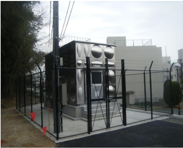
尾津一の谷団地ポンプ所
