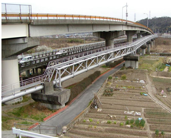
愛宕橋水管橋
