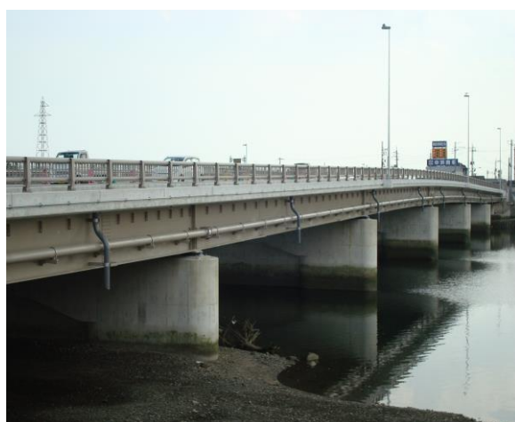
新寿橋添架配水管
