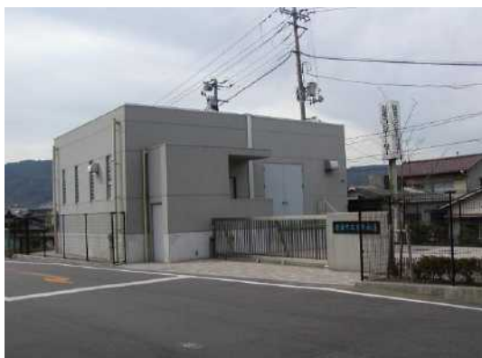
ポンプ所外観
