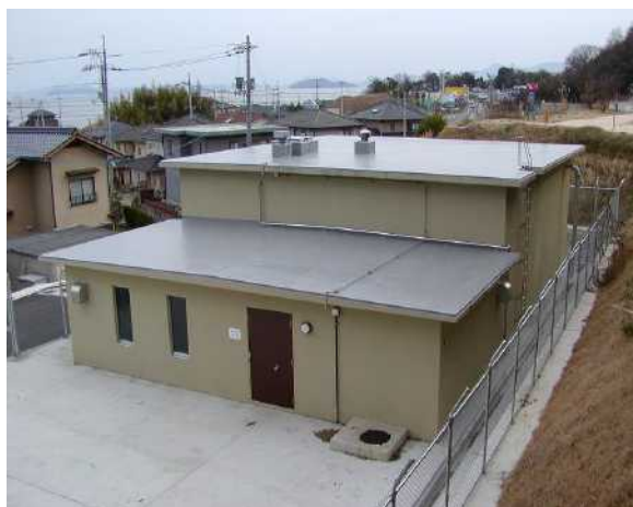
通津ポンプ所
