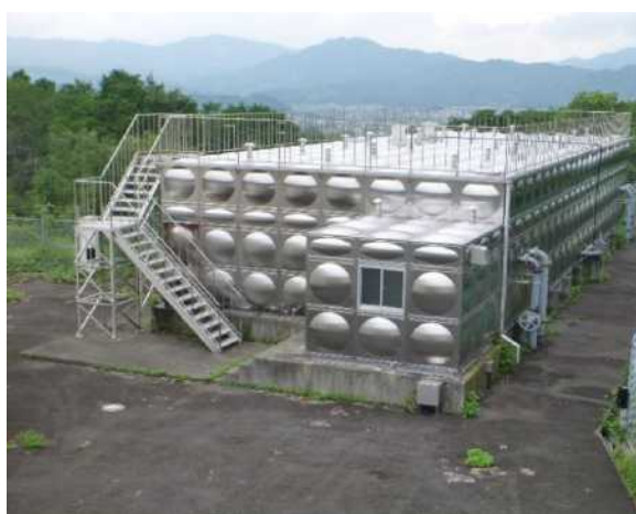
高森南配水池
