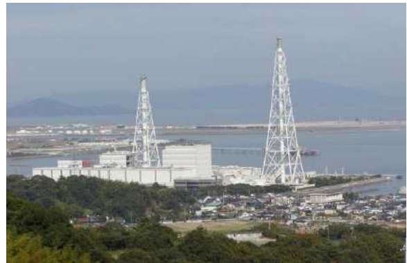
中国電力(株) 岩国発電所
