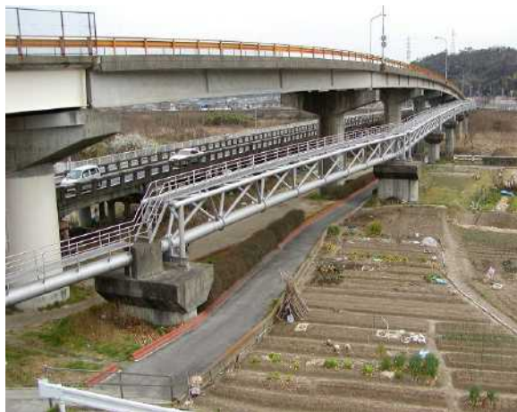
愛宕橋水管橋
