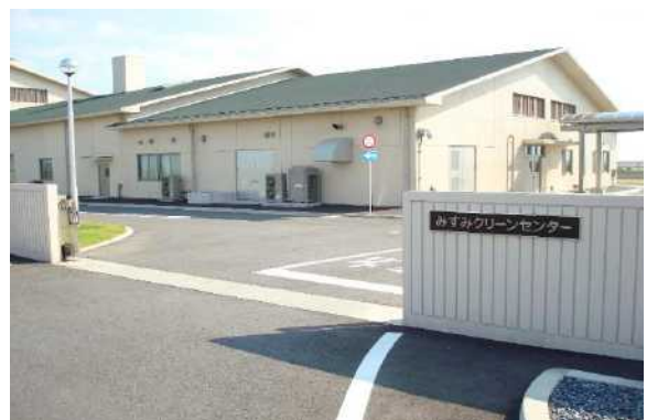
岩国市みすみクリーンセンター
