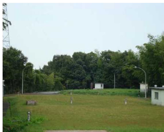
牛野谷配水池
