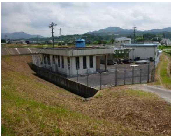
高森南浄水場
