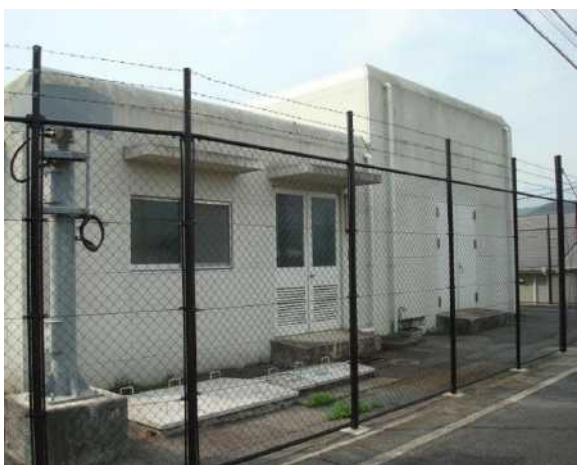
平田ポンプ所
