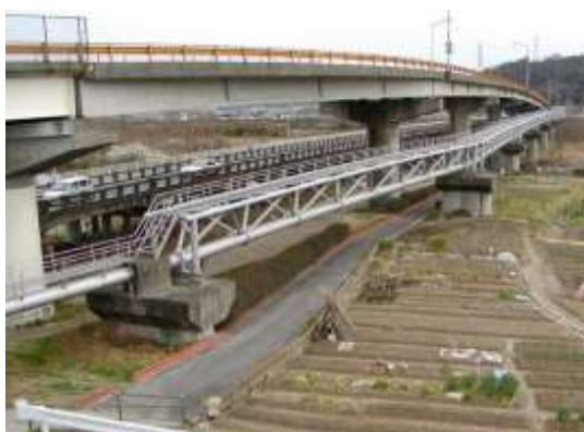
愛宕橋水管橋
