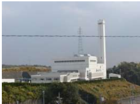
給水先 岩国市第一工場
