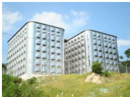
山手ブロック配水池
