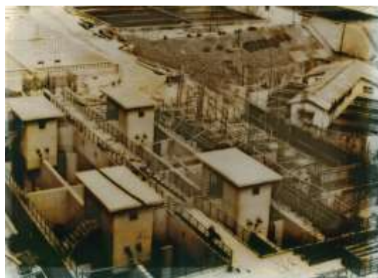
錦見浄水場管理棟（昭和46年工事中）
