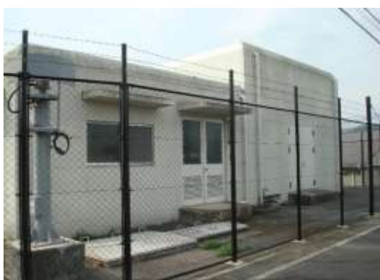
平田ポンプ所
