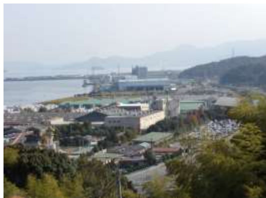
給水先 通津沖工業団地
