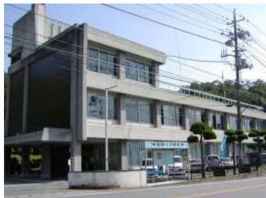
現水道局山手庁舎（山手町4-4-14）
