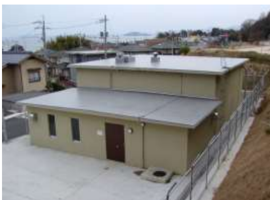
通津ポンプ所
