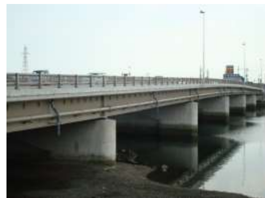
新寿橋添架配水管
