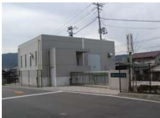
ポンプ所外観
