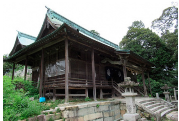
梶杜八幡宮・社殿
