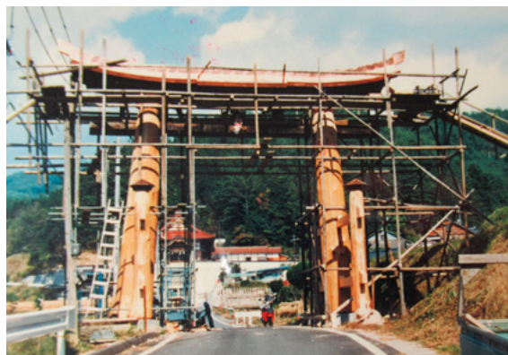
昭和62年（1987）木造両部大鳥居の改修工事（宮田建設提供）
