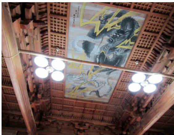
拝殿・折上げ格天井
