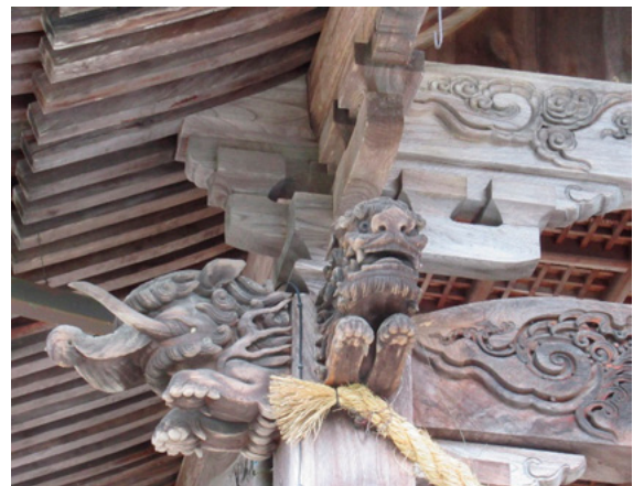
拝殿・二重虹梁の彫刻と斗供
