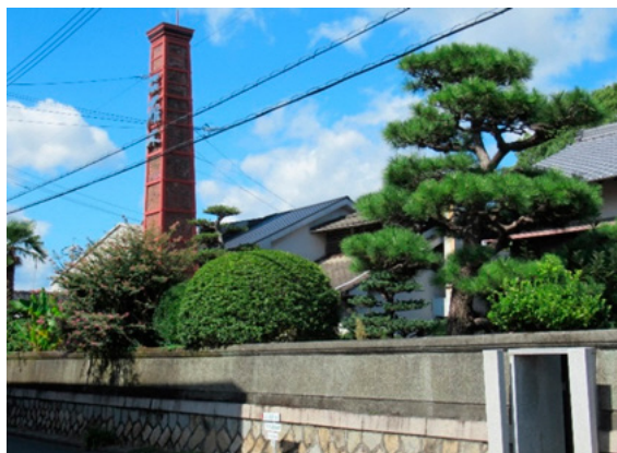
錦川沿いの現在のレンガ煙突
