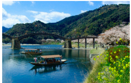
錦帯橋とさくら舟（出典：岩国市ホームページ）
