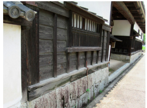
香川家長屋門 正面左側の茶室部分
