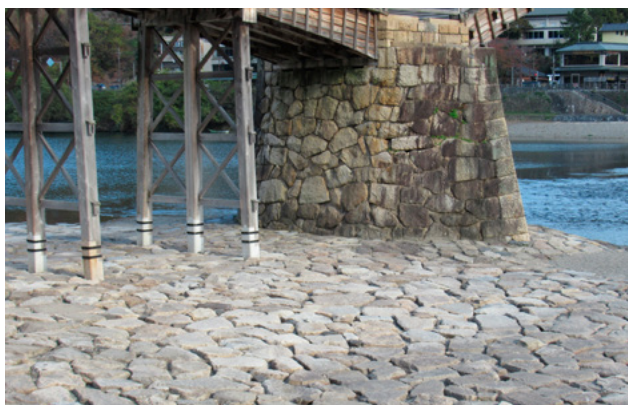
錦帯橋周辺の護床工
