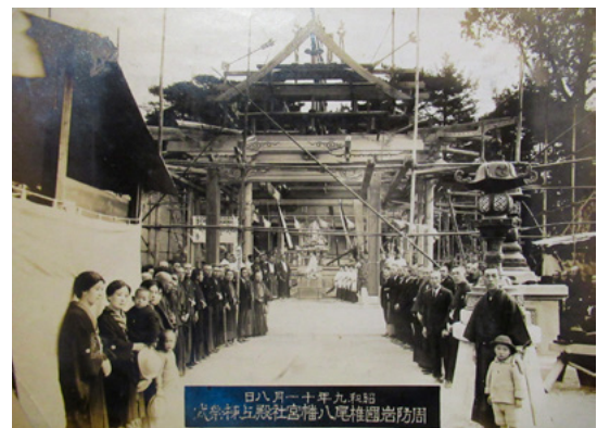
椎尾八幡宮拝殿改築時の上棟式（昭和9年（1934）、中澤家提供）
