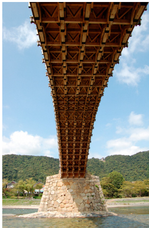
下から見た錦帯橋のアーチ構造（出典：岩国市ホームページ）
