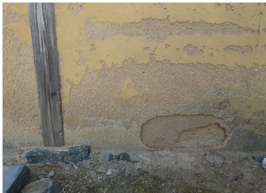
図 2-4-1 外壁の損傷
