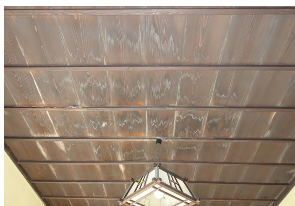
図 1-5-9 天井腐朽
