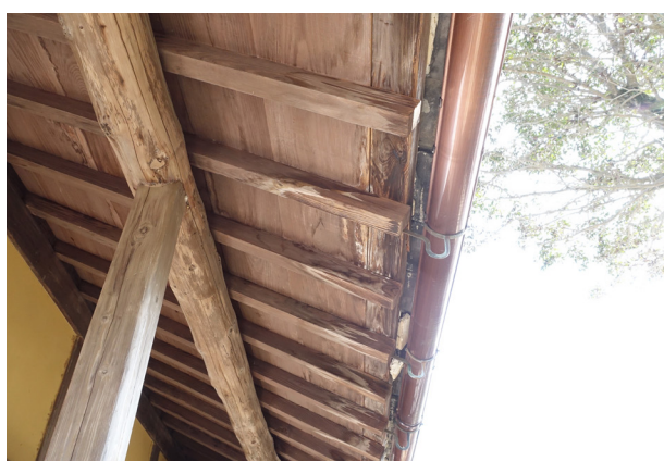
図 1-5-8 軒回り腐朽
