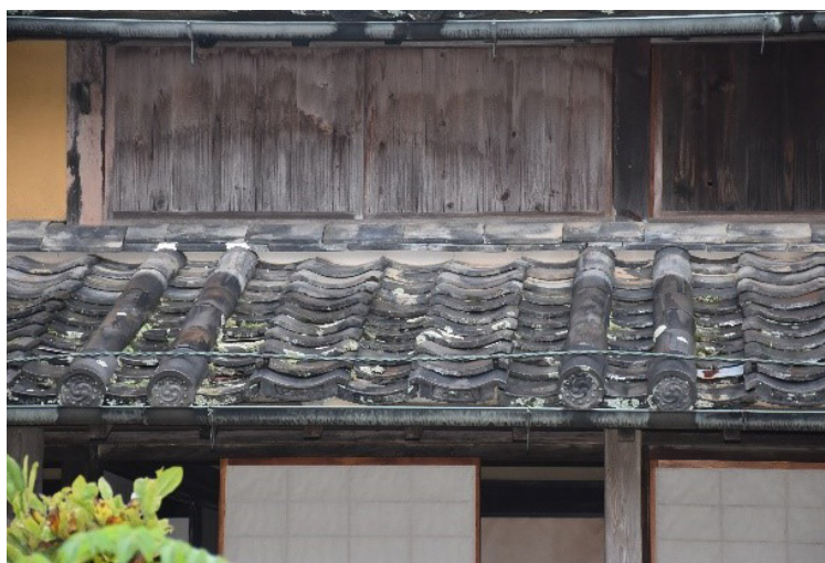
図 1-3-37 両袖瓦と二平葺き
