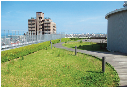
▲ 市役所本庁舎の屋上緑化
