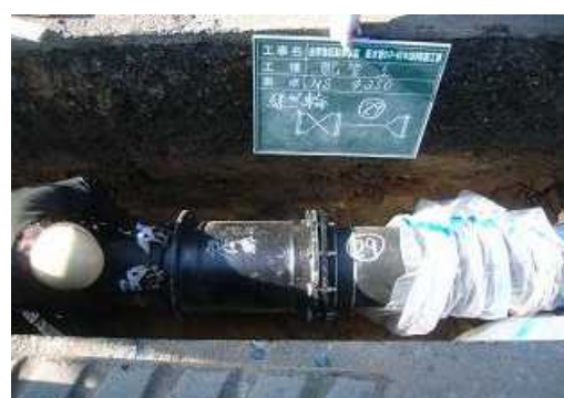
耐震管(NS) 布設工事
