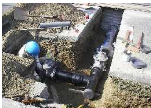
耐震管(NS) 布設工事
