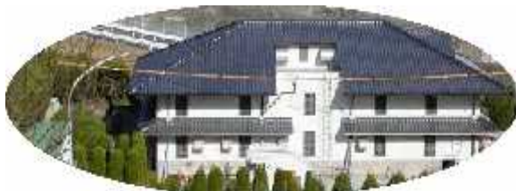
錦見浄水場原水ポンプ室
