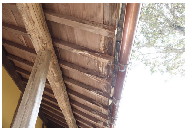
図 1-4-9 軒回り腐朽
