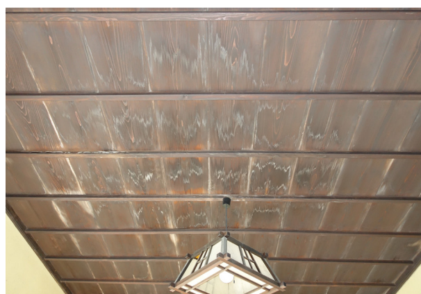
図 1-4-10 天井腐朽
