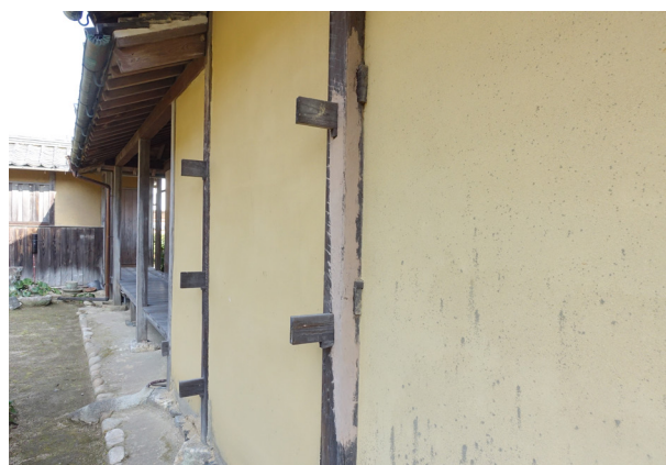
図 1-4-6 柱損傷
