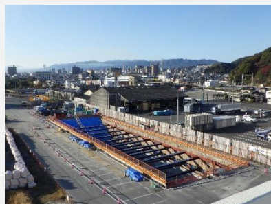
一文宇雨水調整槽 [全景 (工事中)]
