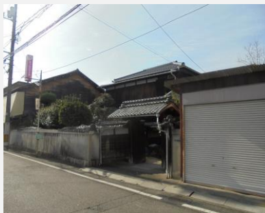
堀・棟門【着手前】
