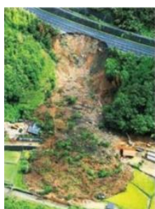
高速道路の崩落
