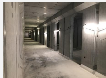
一文宇雨水調整槽 [内部]
