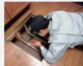
「土台・床組、基礎」調査の様子
