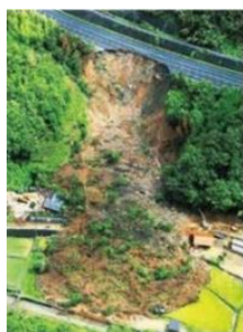
高速道路の崩落
