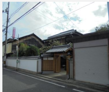
堀・棟門【完成後】
