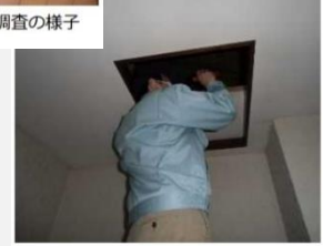
「小屋組・梁」調査の様子
