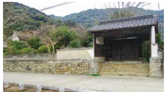
石積みにより基礎を上げる屋敷地
