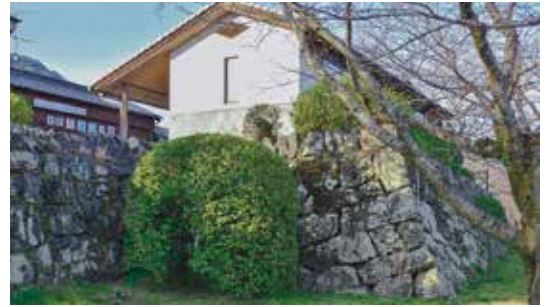
錦川右岸に残る石出し護岸
