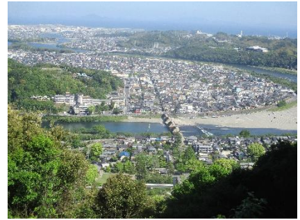
兩岸をつなぐ錦帯橋
