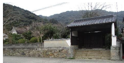
石積による嵩上げ
