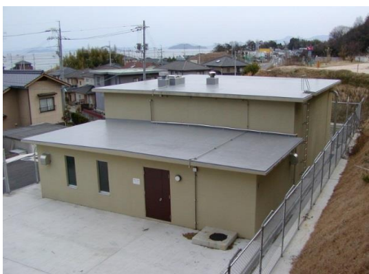
通津ポンプ所
