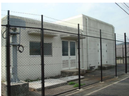
平田ポンプ所
