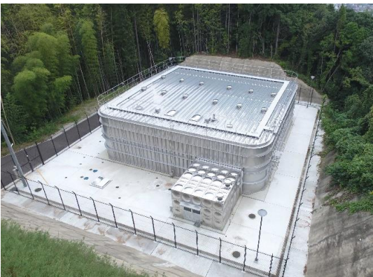
由宇統合配水池
