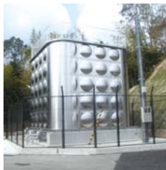
▲耐震化された尾津一の谷配水池
