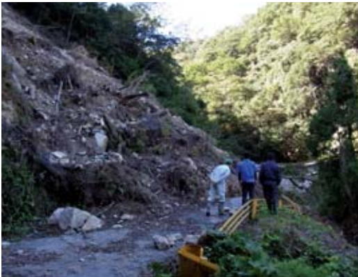
▲現地調査を行う職員ら
