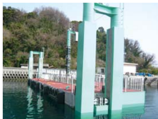
▲完成した浮棧橋
