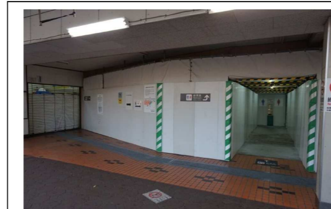
④ 改札外トイレ (歩道側から)
