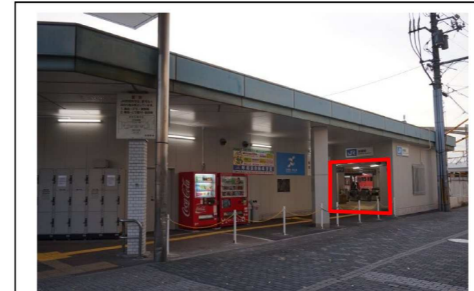
⑤ 新 駅舎出入口 (歩道側から)
