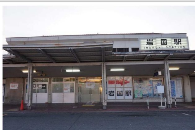
③ 旧 駅舎出入口閉鎖 (歩道側から)
