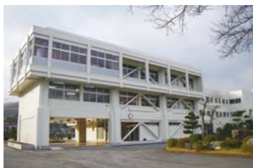
▲中学校施設耐震化推進事業施工例(錦中学校)
