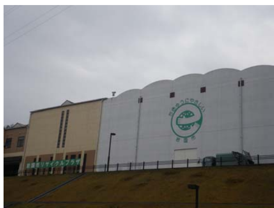
リサイクルプラザ (平成 10 年度完成)
