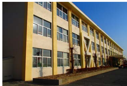
耐震補強工事例
