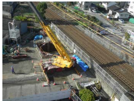
J R 横断部管きょ工事（門前町）
