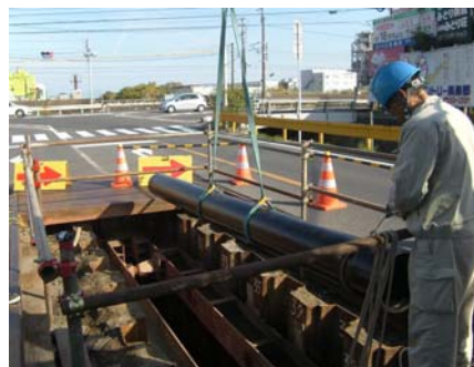
送水管整備工事
