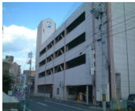
麻里布駐車場
