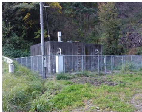
本郷第一配水池
