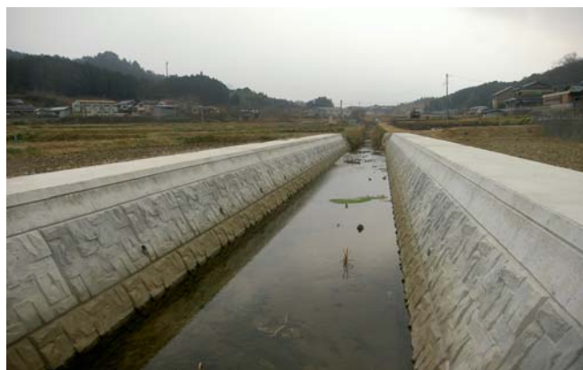
施工例：佐坂川（美和町）
