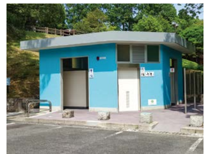
通津美が浦公園トイレ改修事業
