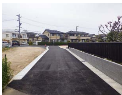
道路改良舗装事業(川下町27号線)
