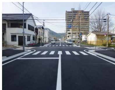
道路改良舗装事業(昭和町13号線)
