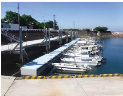
漁港浮棧橋整備事業(通津漁港)
