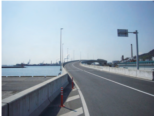
整備が進む臨港道路(新港地区)
