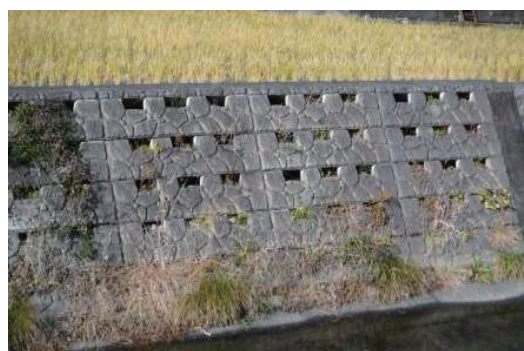
環境に配慮した護岸整備
