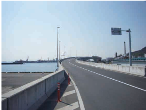
整備が進む臨港道路(新港地区)
