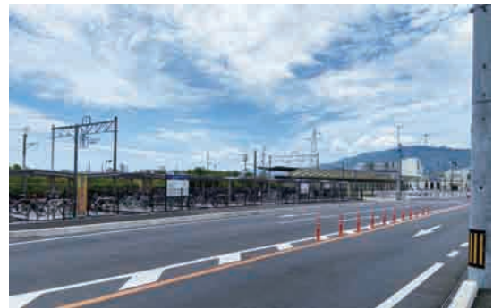
南岩国駅駅前広場の駐輪場
