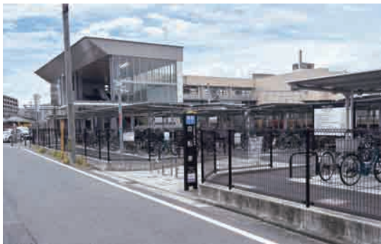
岩国駅駅前広場東口の駐輪場
