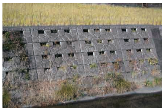
環境に配慮した護岸整備
