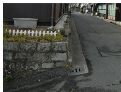
地区内に見られる石積みの擁壁
