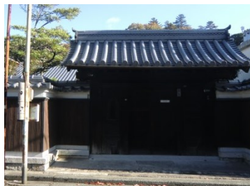
岩国地区に見られる薬医門
