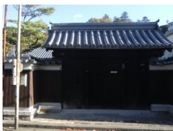
岩国地区に見られる薬医門
