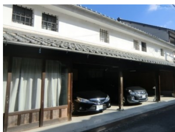
土間の駐車利用と引き戸
