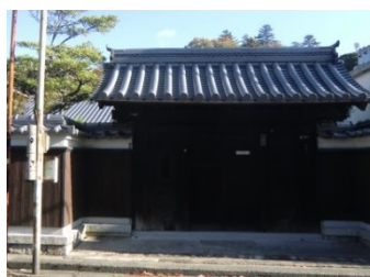
岩国地区に見られる薬医門
