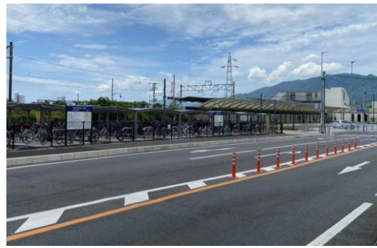
南岩国駅駅前広場の駐輪場
