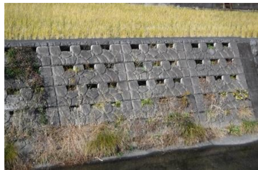
環境に配慮した護岸整備
