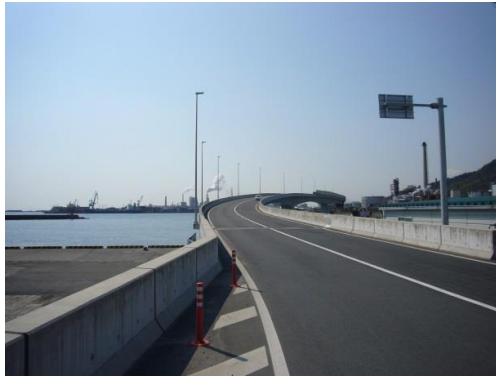
整備が進む臨港道路（新港地区）
