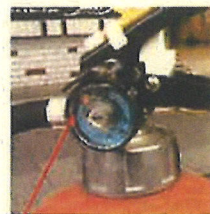
圧力計は緑の範囲が正常（低いと消火薬剤が出ない）
