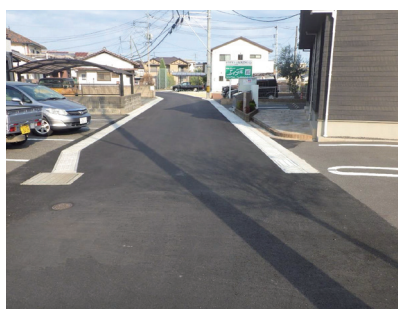
道路改良舗装事業(車町12号線)
