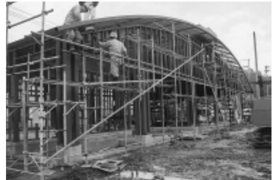
▲ 介護予防拠点整備事業施設建設中
