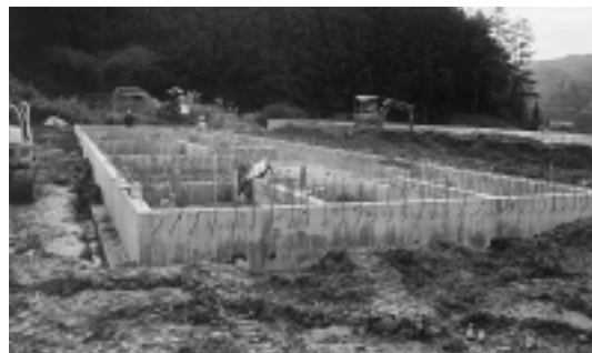
▲ 特産品加工販売施設の基礎工事
