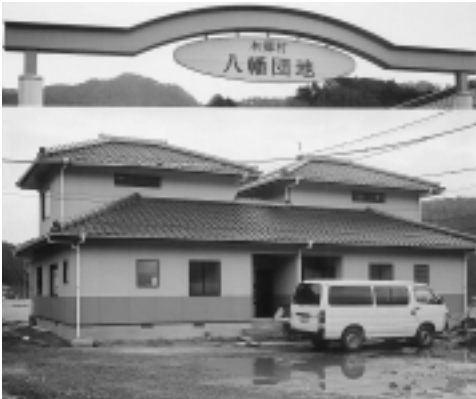
▲ 八幡団地建設中
