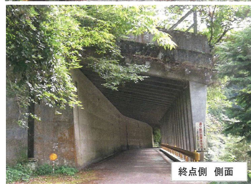
図-1 深川 15 号線ロックシェッド
