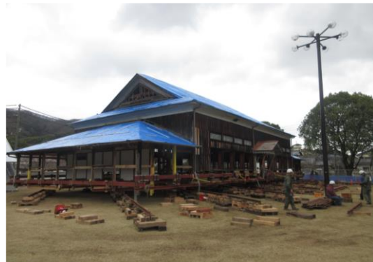
曳き家の様子②
