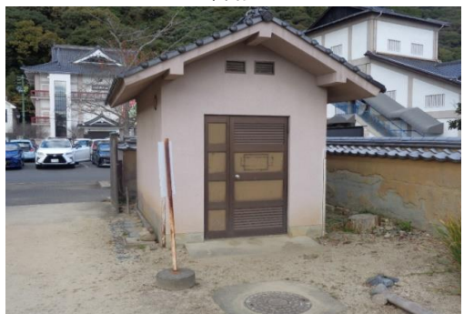
消火ポンプ小屋
