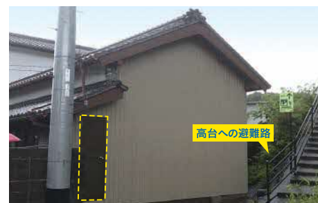
耐震改修と同時に高台への避難路に面して新たに扉が設けられた。
