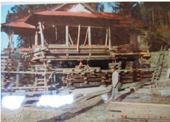
従前拝殿の神楽殿への移築工事 (安村勝利氏提供)
