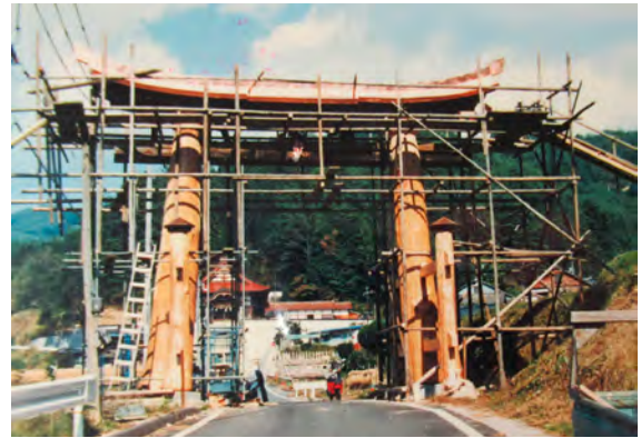
昭和62年(1987) 木造両部大鳥居の改修工事(宮田建設提供)
