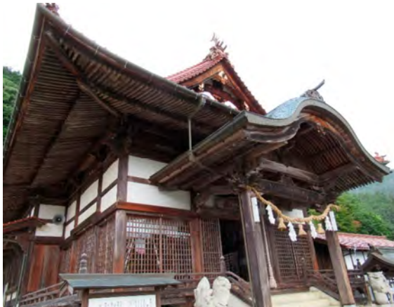
生見八幡宮・拝殿大屋根の軒と向拝
