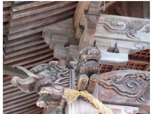
拝殿・二重虹梁の彫刻と斗拱
