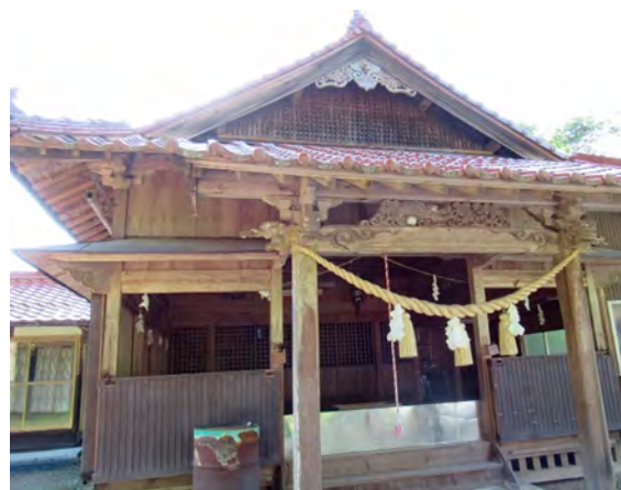
本谷・河内神社拝殿（腰板は可変の神楽舞台装置）
