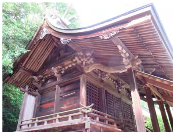
祖生・岩隈八幡宮神殿
