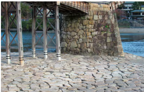
錦帯橋周辺の護床工
