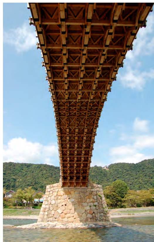
下から見た錦帯橋のアーチ構造 (出典: 岩国市ホームページ)
