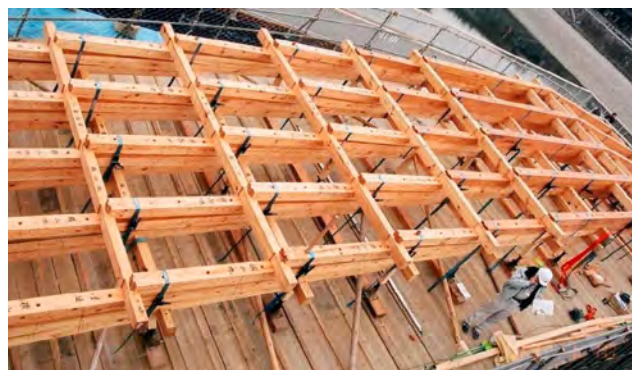
平成の架替え工事時の構造（出典：岩国市ホームページ）
