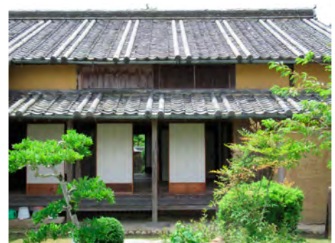
両袖瓦を利用した二平葺きの屋根
