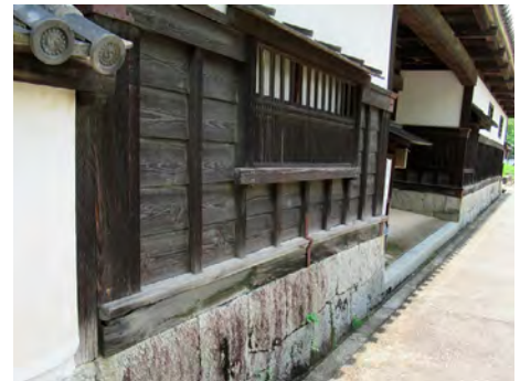
香川家長屋門 正面左側の茶室部分
