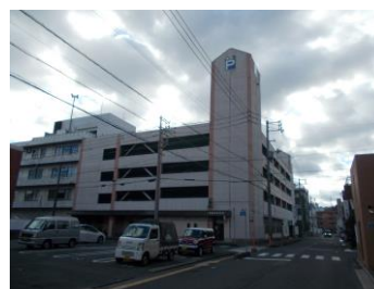
麻里布駐車場
