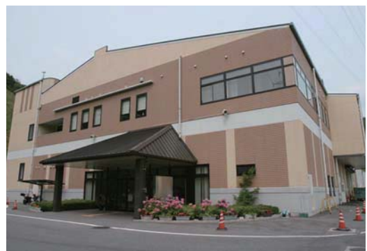
岩国市リサイクルプラザ
