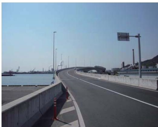
整備が進む臨港道路
