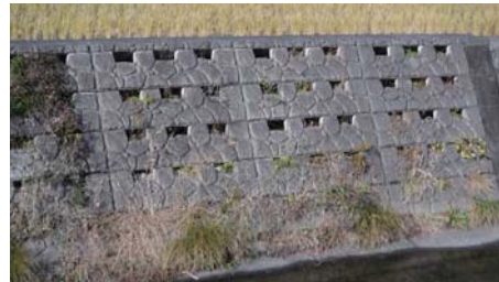
環境に配慮した護岸整備
