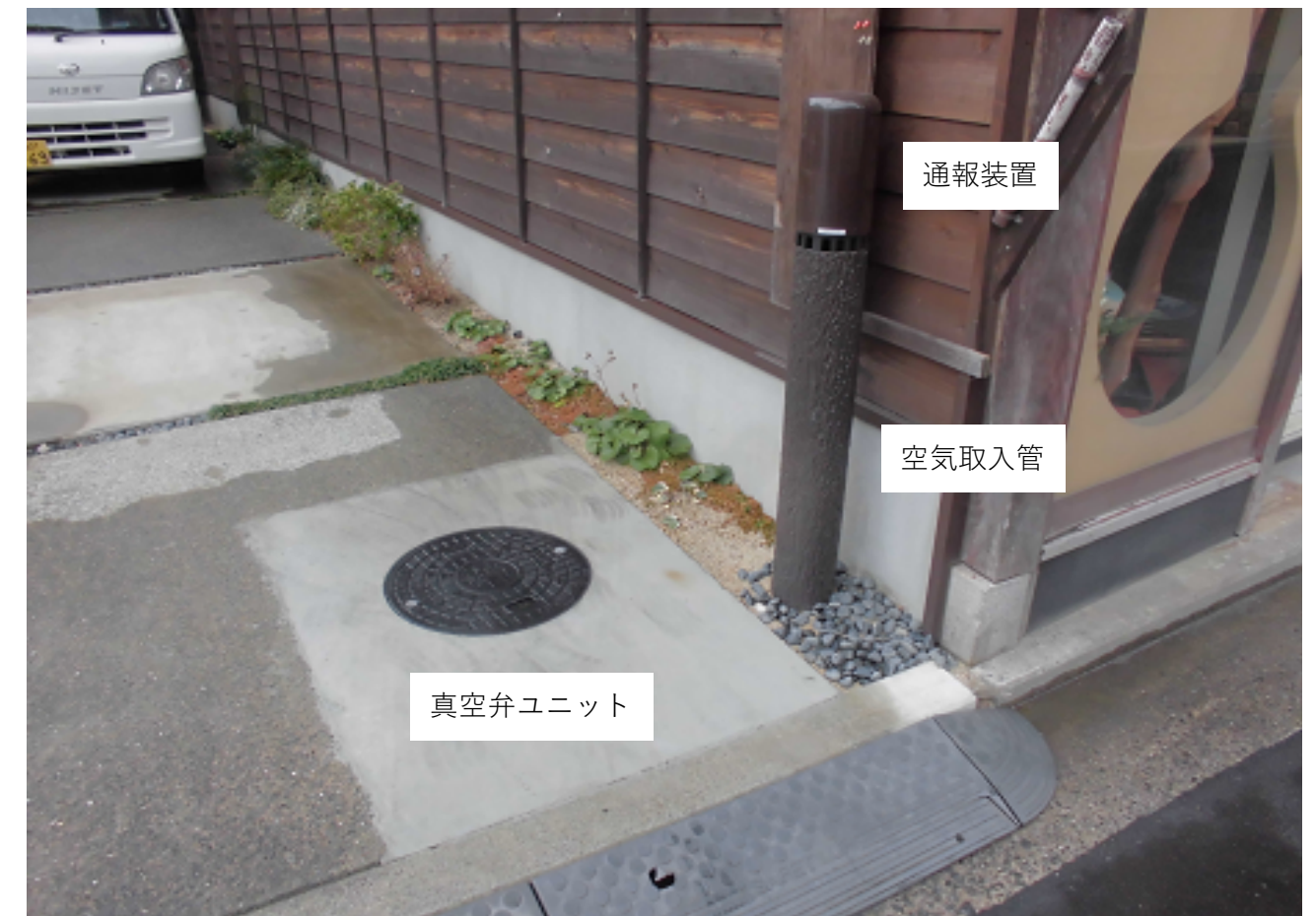
真空弁ユニットの仕組み
