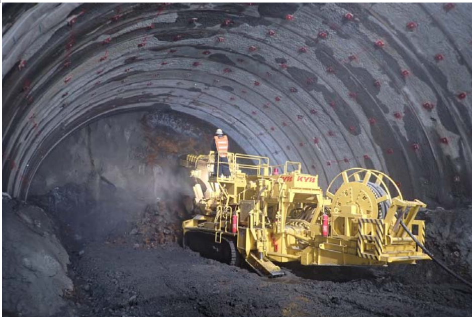
岩国トンネル工事 トンネル内の掘削状況
