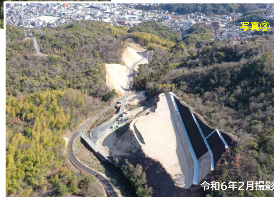
写真③ 広島市方面から 室の木IC（仮称）を撮影
