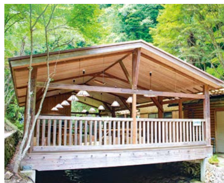
大水車の傍にある補修が完了した休憩処
