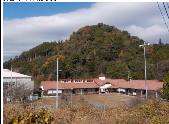
校舎等の外観写真
