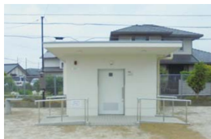
公園施設改修事業
