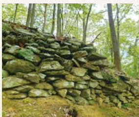
写真…高森城中心曲輪群南側の石積
